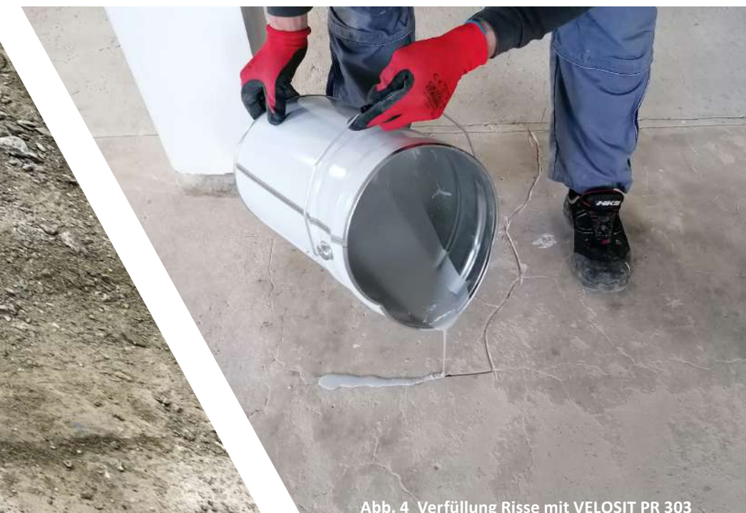
Abb. 4 Verfüllung Risse mit VELOSIT PR 303
